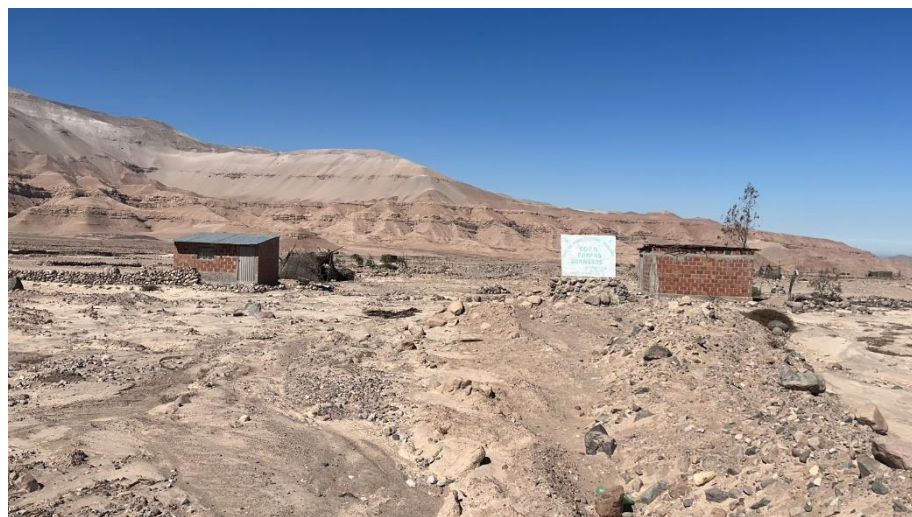
Fotografía 4: Asociación de Agricultores Pequeño Edén, se observan algunas infraestructuras deshabitadas y cerradas. (10 – 11 de junio, 2023)
